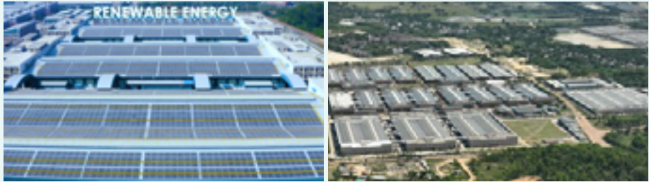
방글라데시 태양광 발전설비
