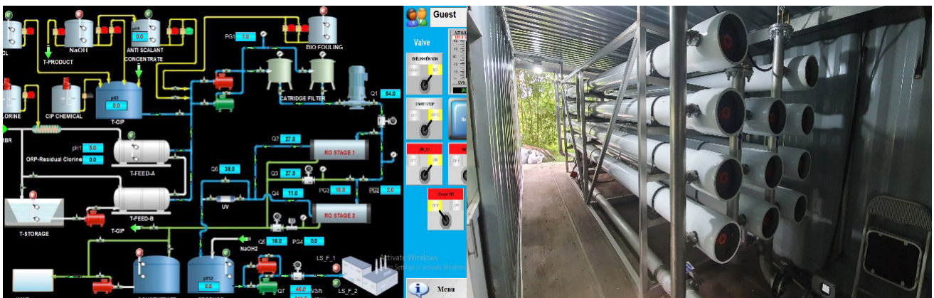
Figure 9. 베트남 공장 RO 수처리 설비
