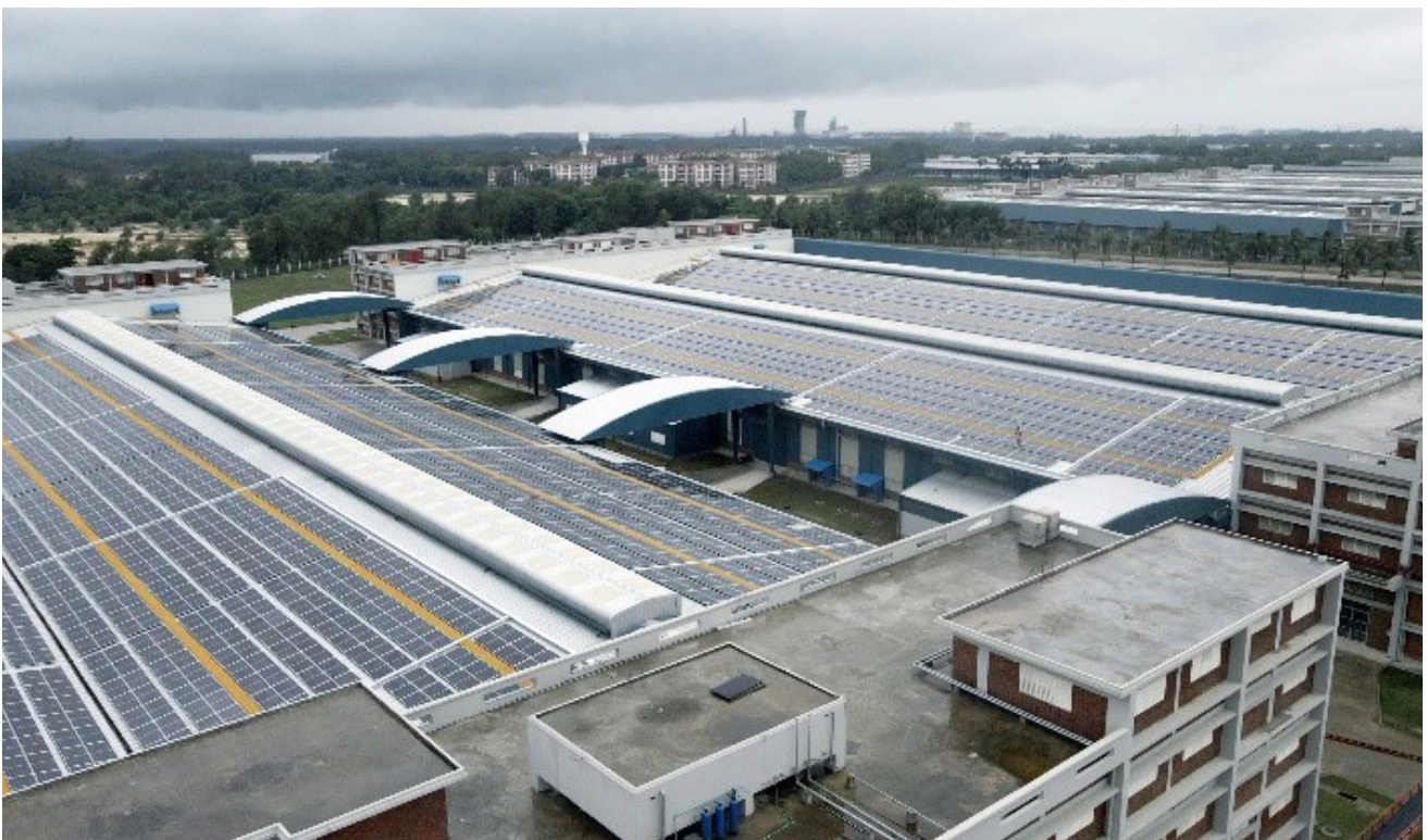
Figure 6. 내 시공된 태양광 패널
