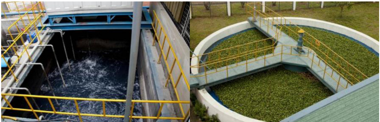
Figure 8. 방글라데시 공장 ETP 수처리 설비
